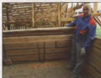
Сгнившая в пазу часть бревна, выявленная при разборке
