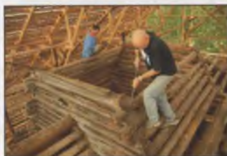
Часть сруба, вопреки правилам реставрации сбита на гвоздях
