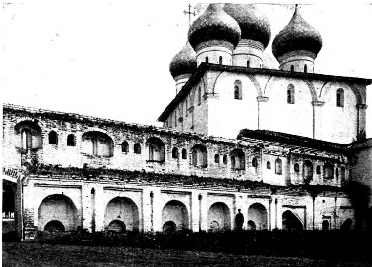
Рис. 35. Восточная стѣна ограды Архіерейскаго дома.
