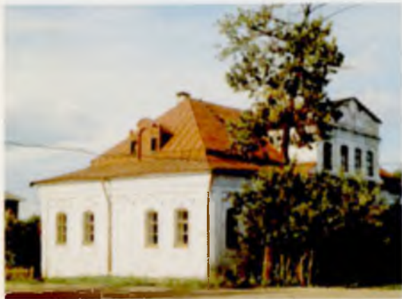
Великий Устюг. Деревянный дом Конец XIX в. Veliky Ustiug. A wooden house. Late 19th century
