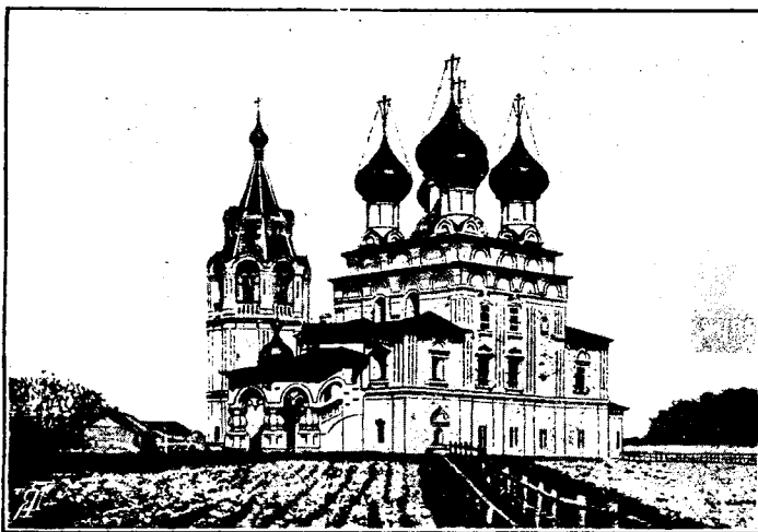
Царе-Константиновская церковь въ г. Вологдѣ. Построена въ 1690 году.
