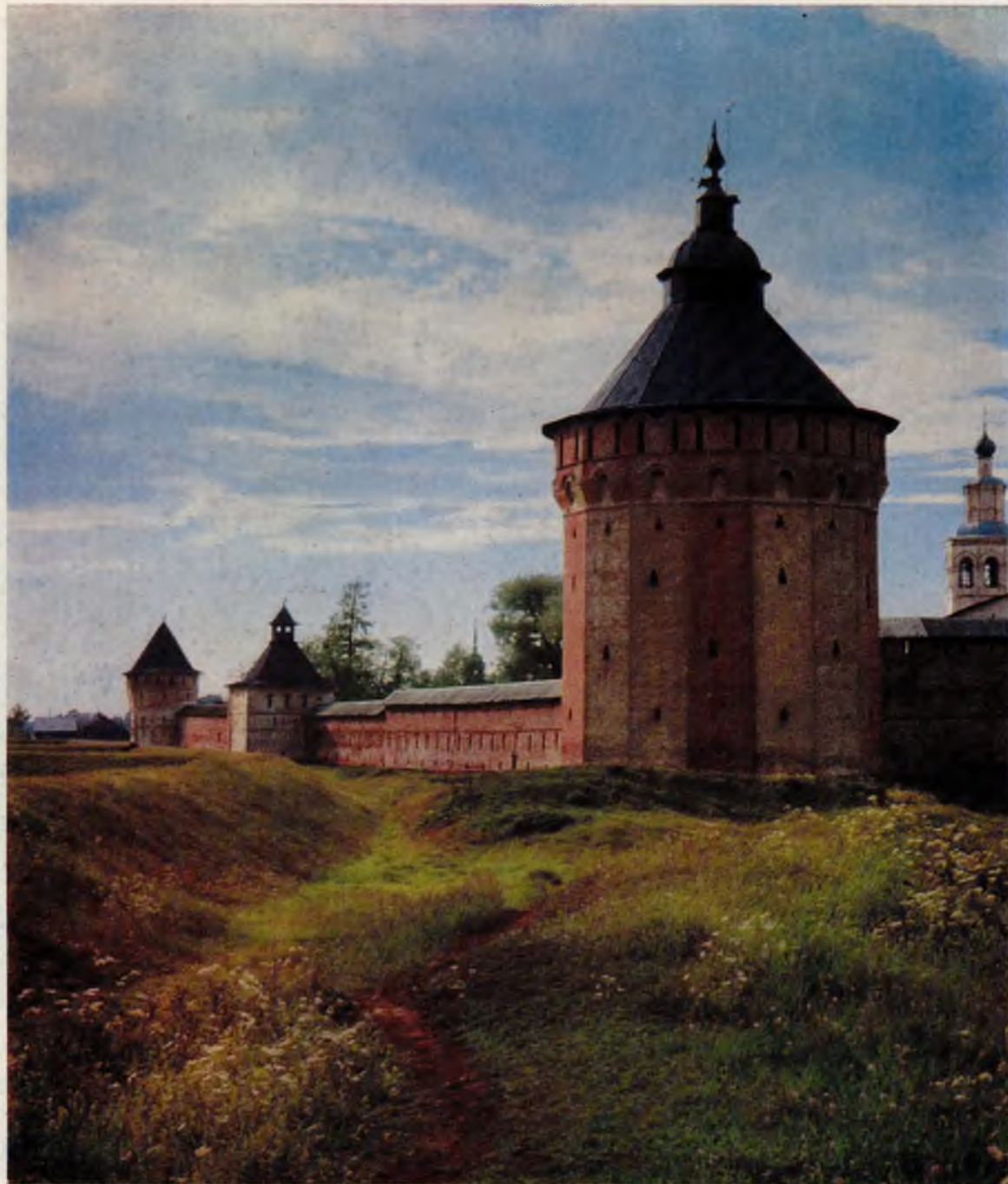
West wall tower Башня западной стены
