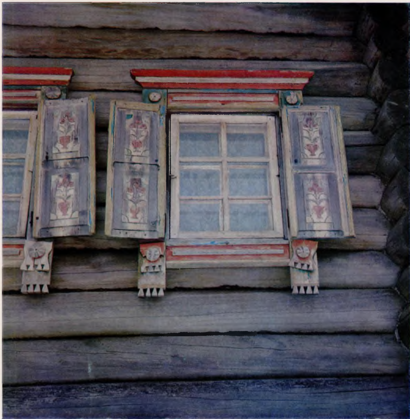
Village of Zaozerye. Klokotov house. Window shutters Село Заозерье. Дом В. Я. Клокотова. Оконные ставни
