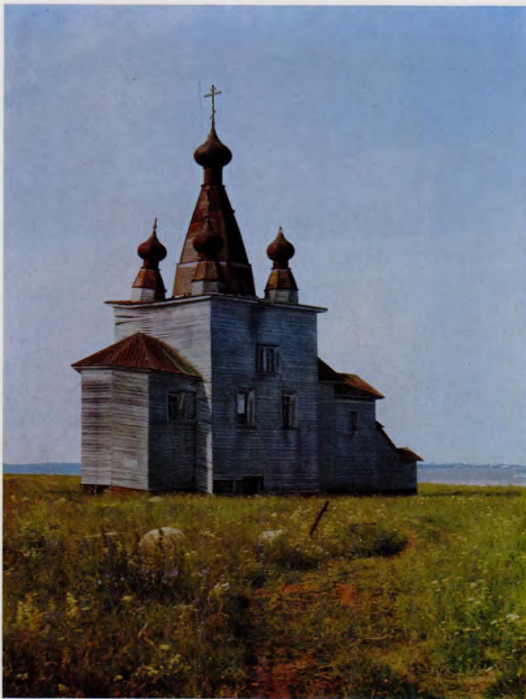
Archangel region, Kholmogory district. Village of Rakuly. Church of the Resurrection. 1766 Архангельская область. Холмогорский район. Село Ракулы. Воскресенская церковь. 1766
